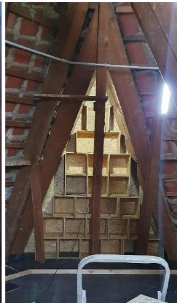
Verschluss des Hohlraums hinter den Nistzellen aufgrund unregelmäßigem Wandaufbaus in den drei Giebeln (Abstände bis zu 10 cm) zur Verhinderung der Verkotung des Hohlraums hinter den Nistzellen bzw. dahinter fallen von Tieren.
