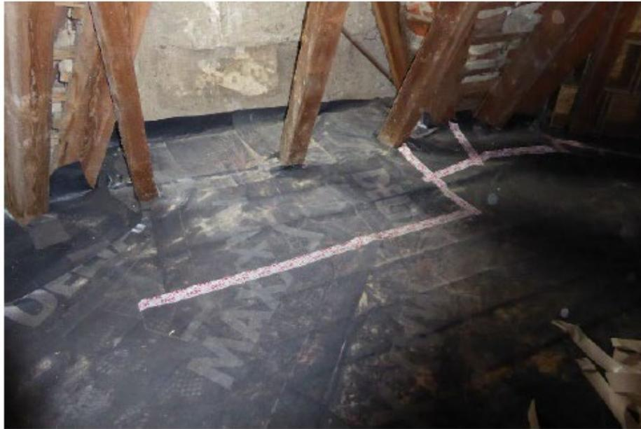
Vorhandene Fußbodenbohlen mit einer hochwertigen Dachspannbahn belegt.
